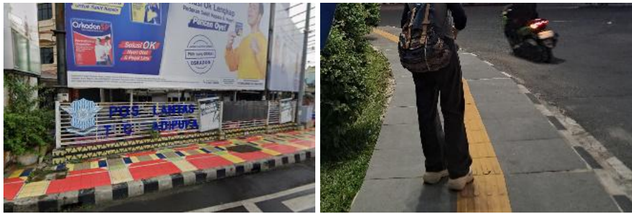
(a) Tidak Memiliki Pagar Pengaman (b) Infrastruktur Disabilitas
